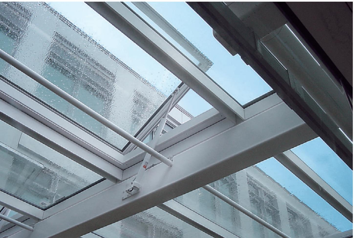
Die Spindelantriebe der Unternehmensgruppe Gretsch-Unitas eignen sich optimal zum Öffnen und Schließen von großen und schweren Dachfenstern oder Fassadenöffnungen.
