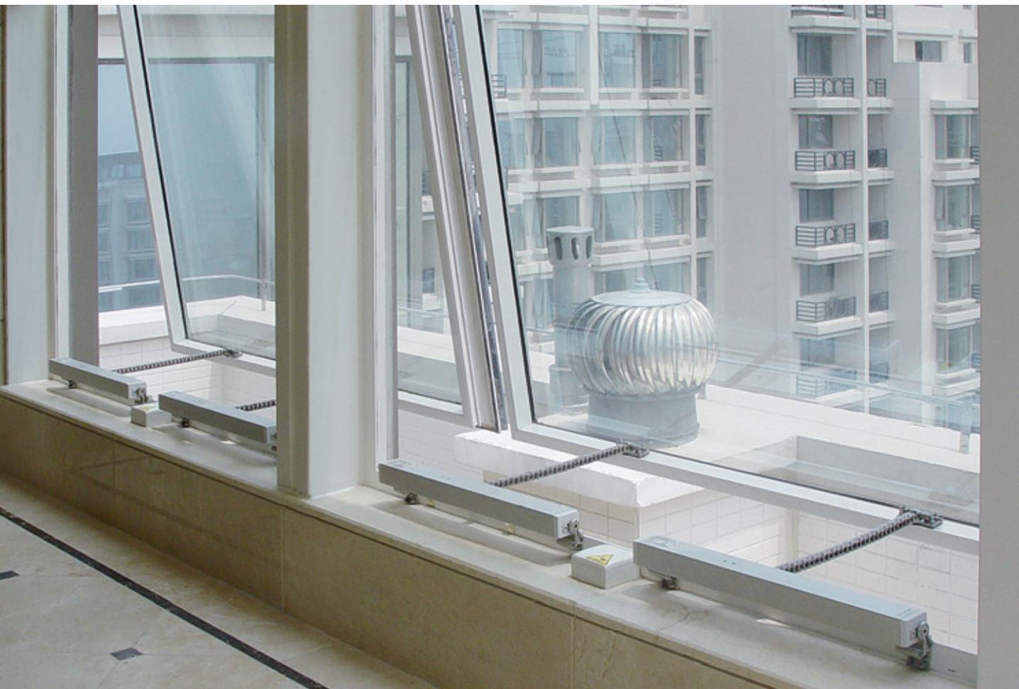
Mit einem Programm an unterschiedlichen Oberlichtöffnersystemen sowie Ketten- und Spindelantrieben bietet die Unternehmensgruppe Gretsch-Unitas individuelle Lösungen für die komfortable, tägliche Raumlüftung.
